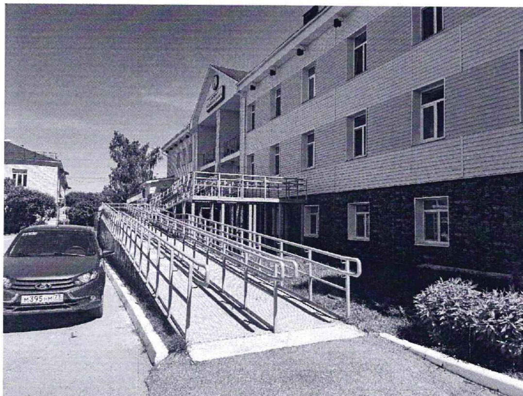
Здание (Пандус центральный)
