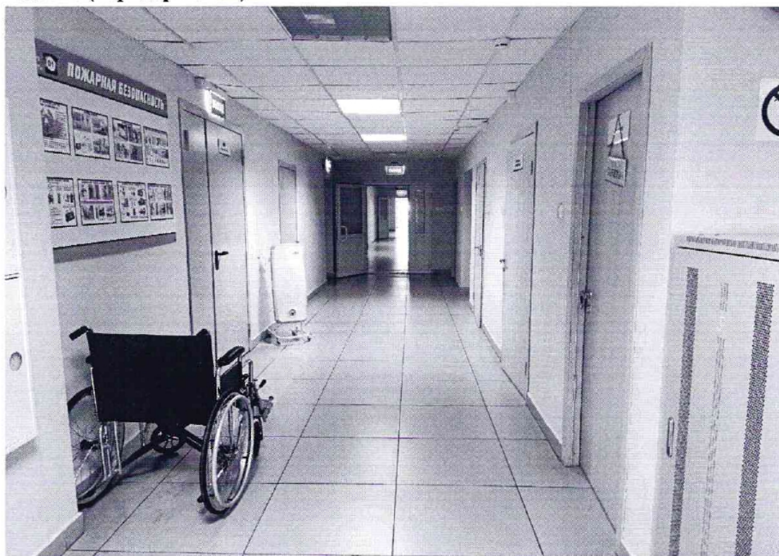
ФОТО 5 Здание (коридор 1 этаж)
